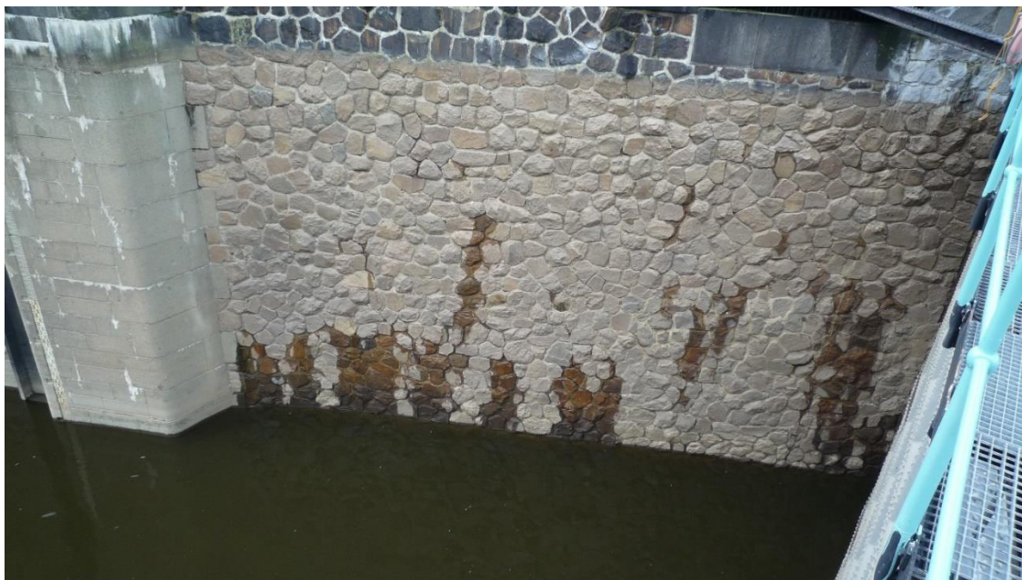
Foto 3 : Typická struktura sanovaného zdiva
